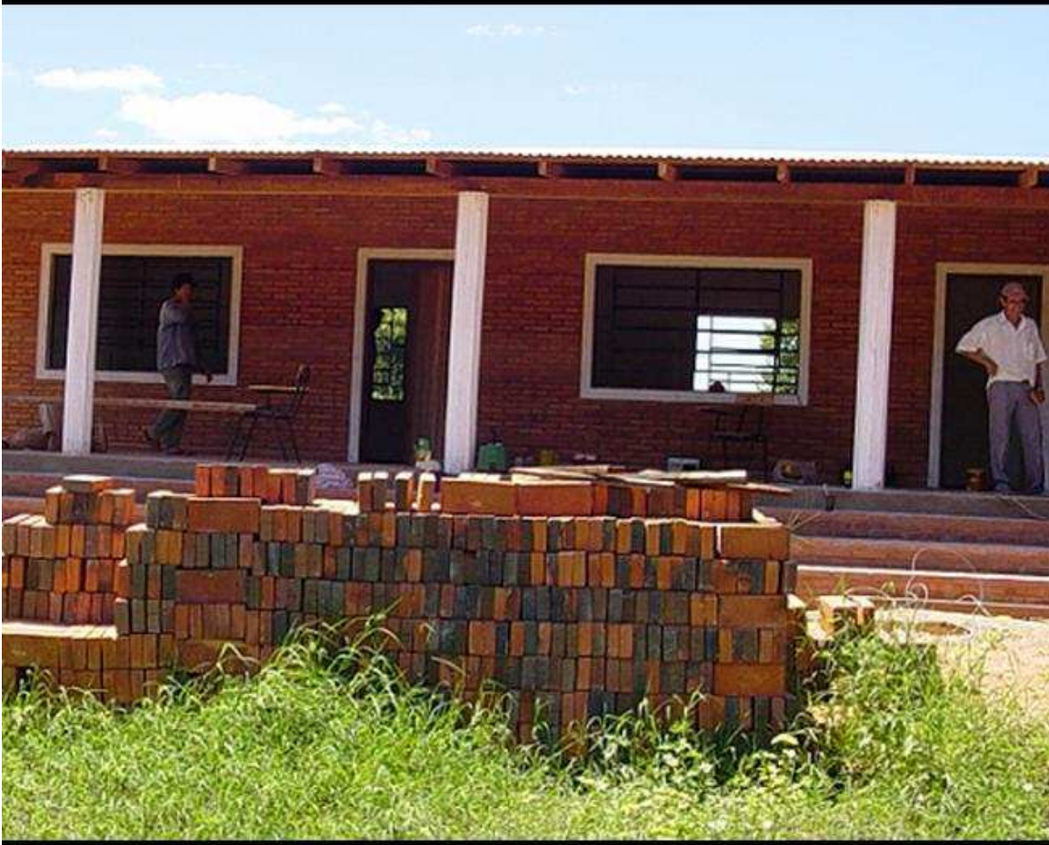
Construcción de la Escuela de Cuatro Vientos, 1999
